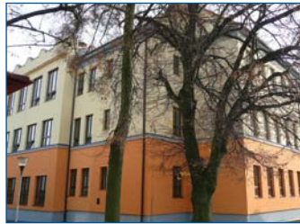
2008 – Zateplení a výměna otvorových prvků hlavní budovy ZŠ
