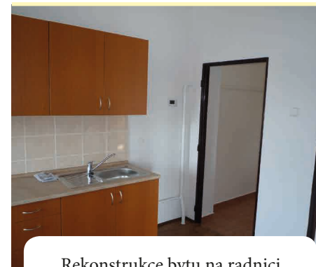
Rekonstrukce bytu na radnici
