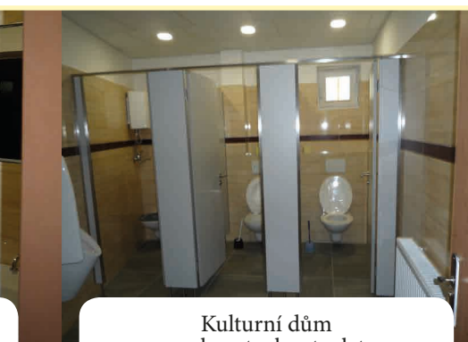
Kulturní dům - rekonstrukce toalet
