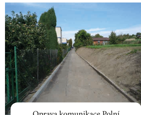
Oprava komunikace Polní
