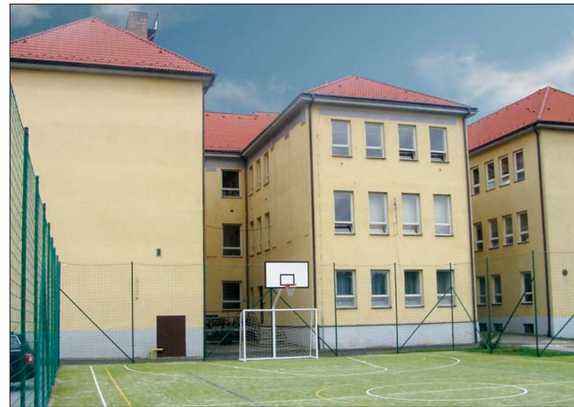
Jižní strana budovy s pozdějšími přístavbami a novým hřištěm
