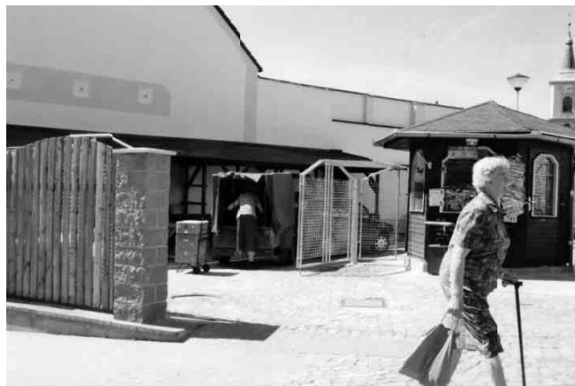
Opravená tržnice na nám. Míru
