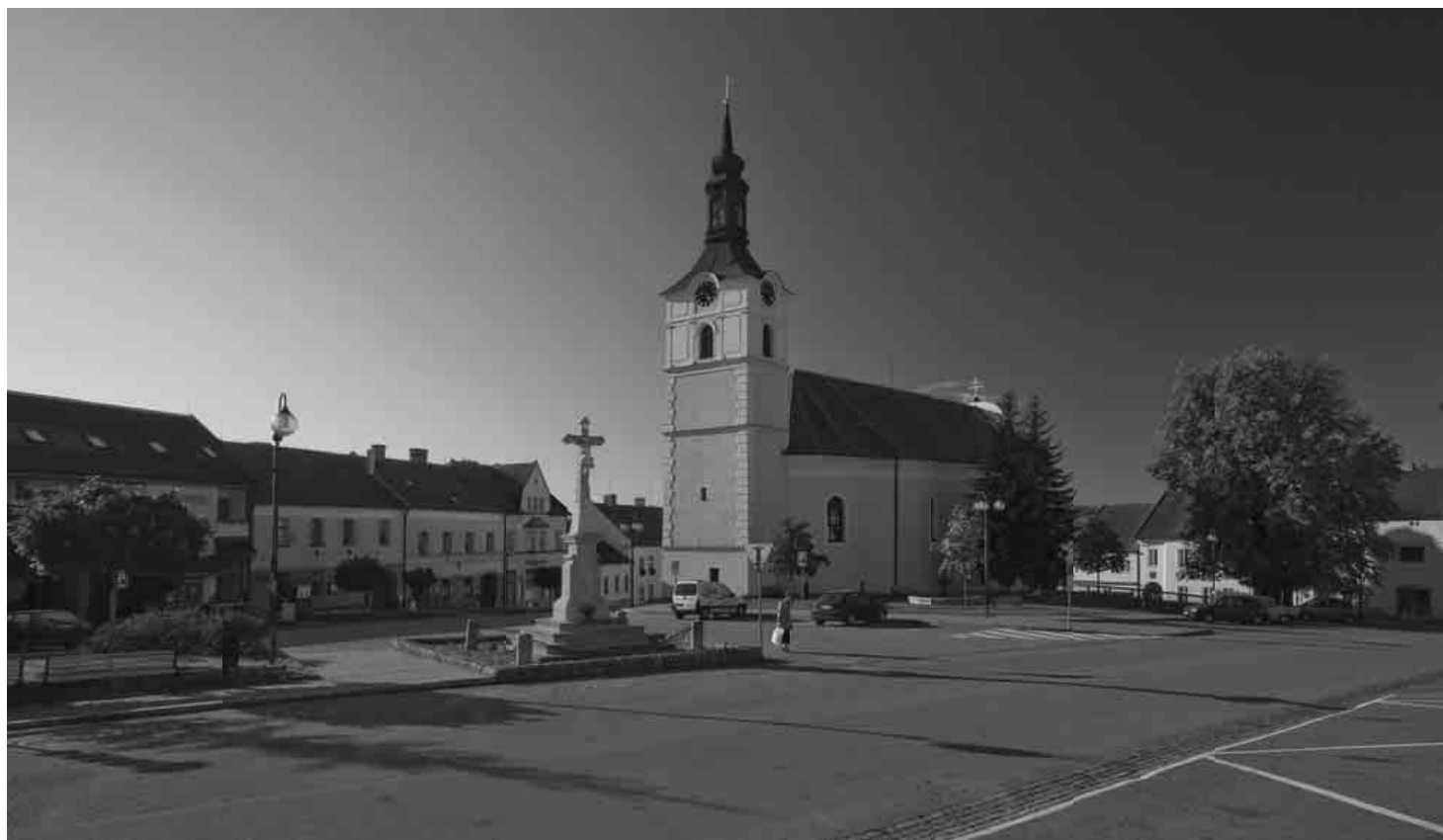
Opravený kříž na náměstí
