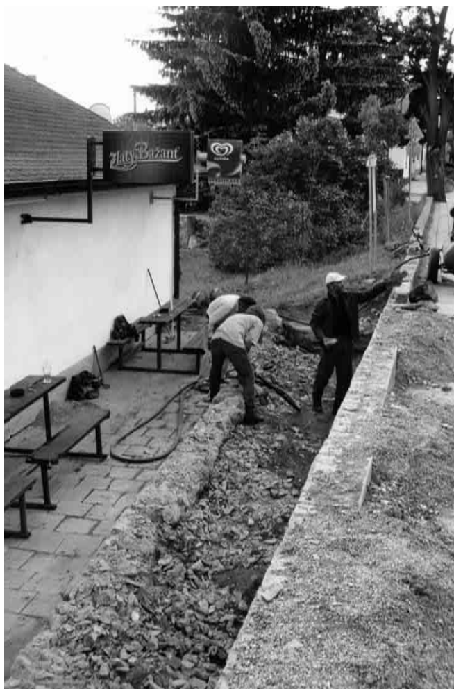
Stavba letní zahrádky u koupaliště
