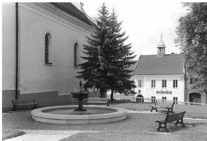
Pohled na věžičku a opravenou střechu radnice.
