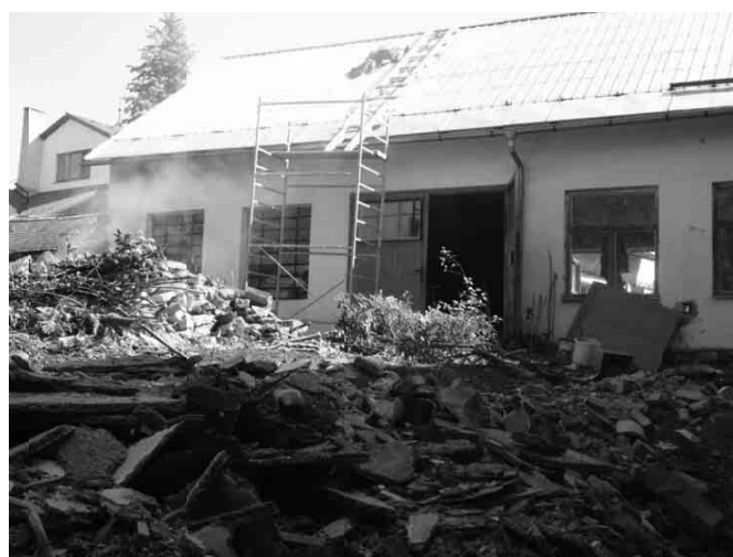
Přestavba domu služeb na knihovnu a muzeum
