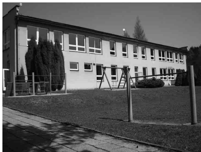
Budova MŠ po výměně oken
