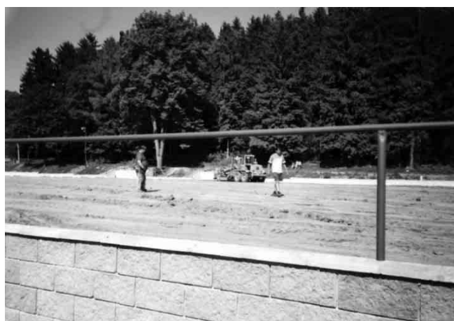
Opěrná zídka vybudovaná za účelem zvedání úrovně hrací plochy
