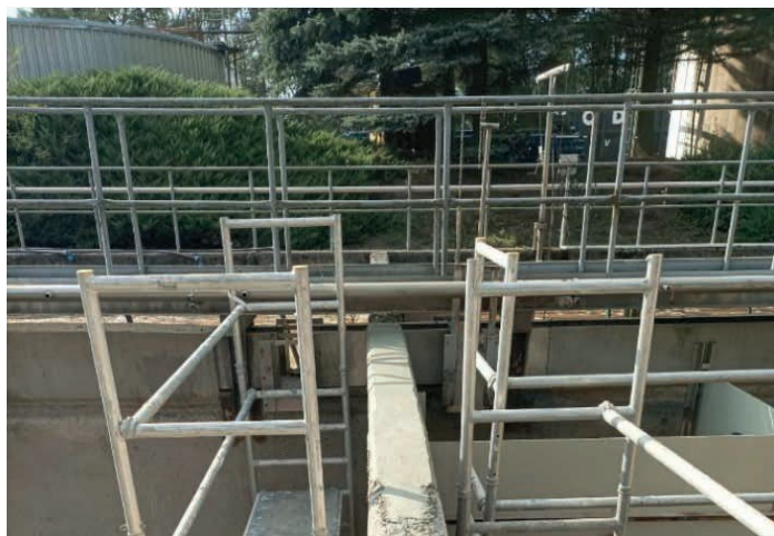
Nové opravy – sanování stěn a zborcených příček, které po sobě zanechala stopa času
