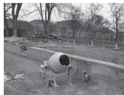
Výstavba přístřešku v zahradě KD
