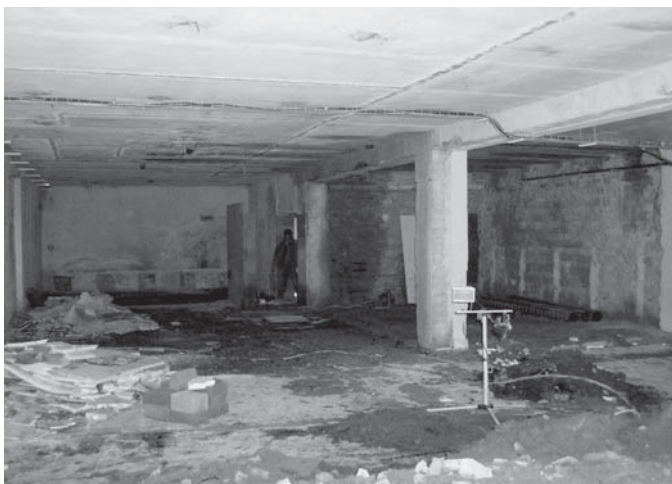
Demoliční práce v hotelu Závřší
