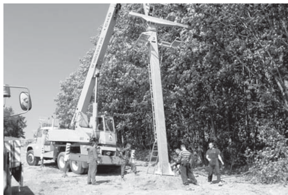
Výstavba nového vleku
