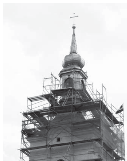
Výměna střechy věže kostela
