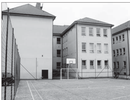
Nové hřiště s umělým povrchem
