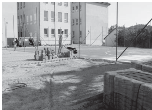
Výstavba parkoviště u hřiště
